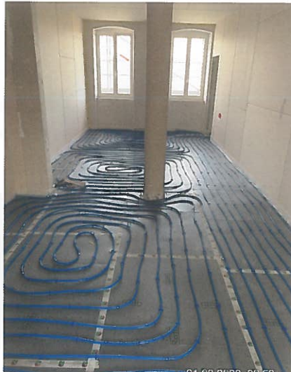
Abb. 26: ... alle Heizungen durch Zentralheizungen mit Fernwärmeanschluss ersetzt und ... [© Ulreich Baurträger GmbH]
