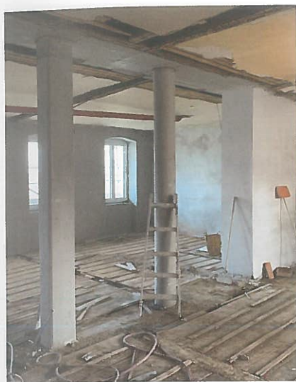
Abb. 11: Sanierung und Verstärkung der Wohnungen im Regelgeschoss [© Ulreich Baurträger GmbH]
