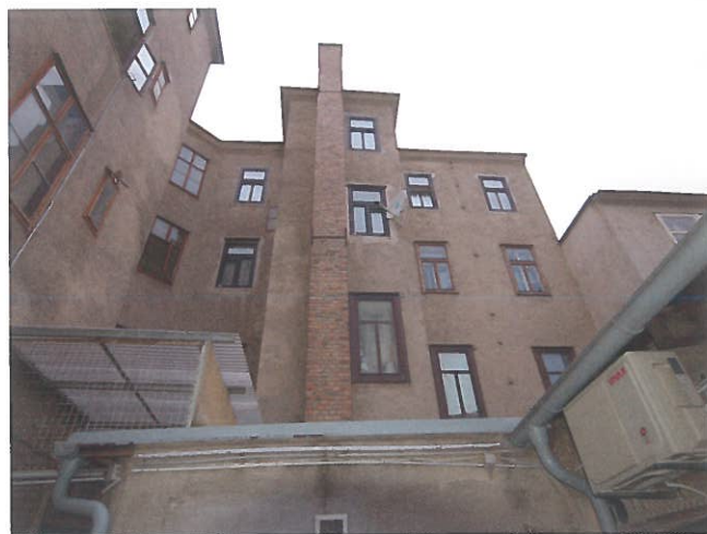
Abb. 3: Die Innenhoffassade [© Ulreich Baurträger GmbH]
