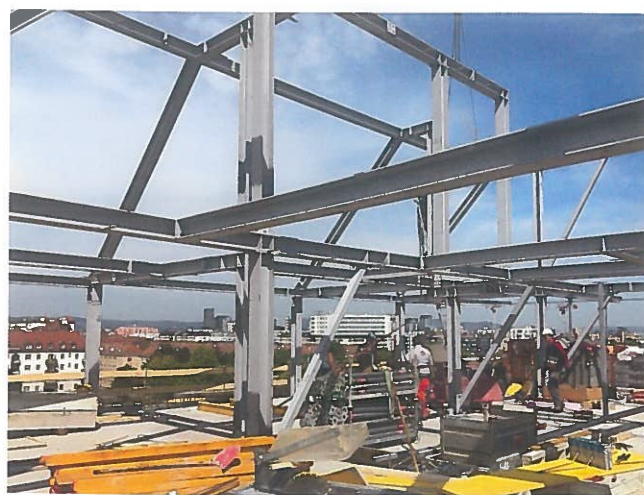
Abb. 18: ... bzw. in Stahl-Holz-Bauweise (1. und 2. DG) [© Ulreich Bauträger GmbH]
