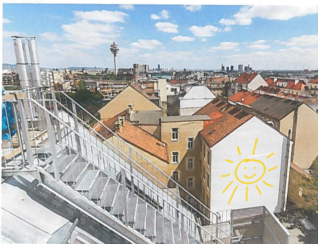
Abb. 31: Sonnen-Smiley auf der Feuerwand des Nachbargebäudes [© Ulreich Bauträger GmbH]
