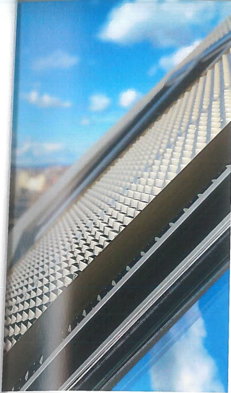
Abb. 32 und 33: Ein architektonisches und optisches Highlight: das neue Dachgeschoss des »Favorite Spring« mit seiner zweiten Haut aus bronzefarbenem Streckmetall [links: © Ulreich Baurträger GmbH, rechts: © Allahyari PR / Henninger]
