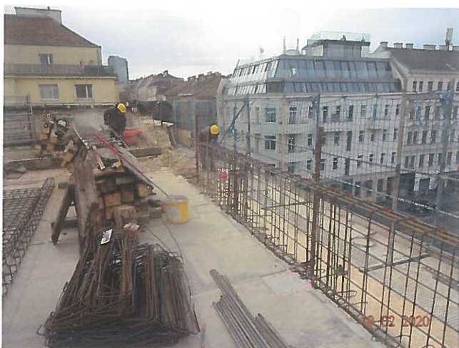
Abb. 17: Errichtung der dreigeschossigen Dachaufstockung in Stahlbeton (4. OG) ... [© Ulreich Bauträger GmbH]
