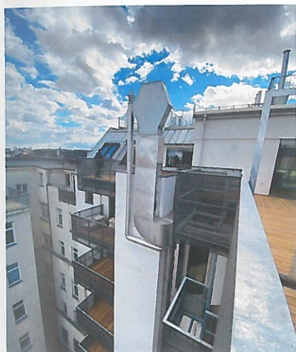
Abb. 12: Neue hofseitige Balkone [© Ulreich Baurträger GmbH]
