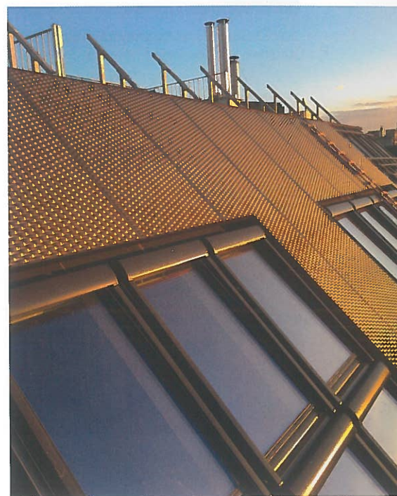
Abb. 15: ... mit einer zweiten Haut aus bronzefarbenem Streckmetall [© Ulreich Baurträger GmbH]
