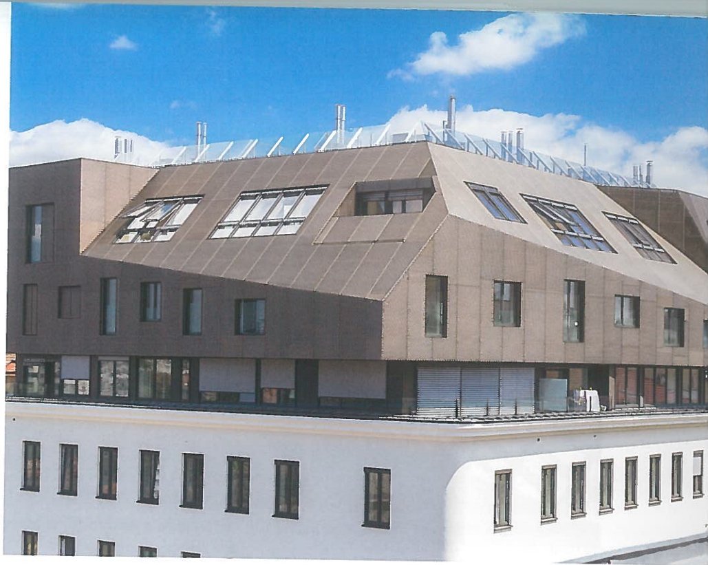
Abb. 32 und 33: Ein architektonisches und optisches Highlight: das neue Dachgeschoss des »Favorite Spring« mit seiner zweiten Haut aus bronzefarbenem Streckmetall [links: © Ulreich Baurträger GmbH, rechts: © Allahyari PR / Henninger]
