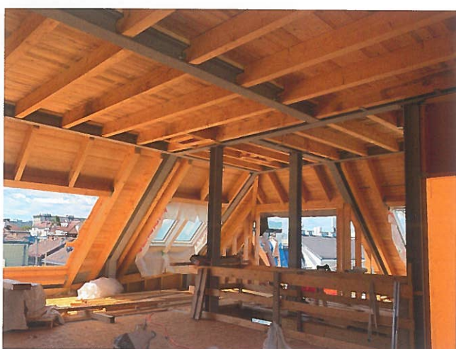
Abb. 19: 2. DG in Stahl und Holz [© Ulreich Bauträger GmbH]
