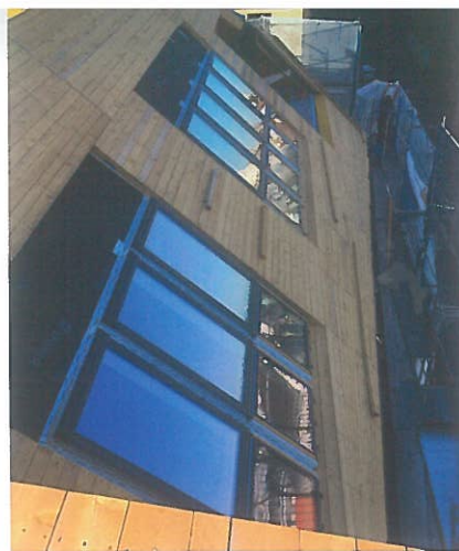
Abb. 14: Dachaufbau der Aufstockung ... [© Ulreich Baurträger GmbH]
