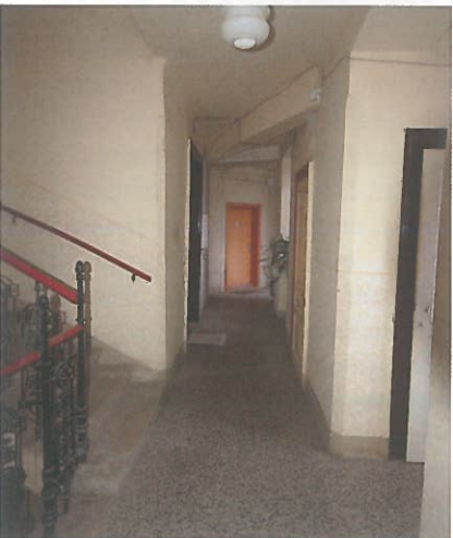
Abb. 7: Das Stiegenhaus [© Ulreich Baurträger GmbH]
