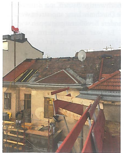
Abb. 10: Abtrag des maroden Dachstuhls [© Ulreich Baurträger GmbH]
