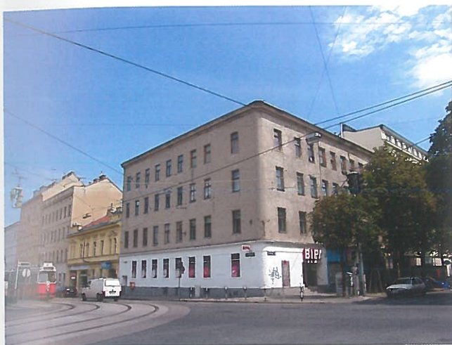
Abb. 2: Das Gebäude vor der Sanierung [© Ulreich Baurträger GmbH]
